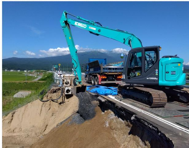
林建設工業株による路肩崩落の復旧(盛土材充填)
