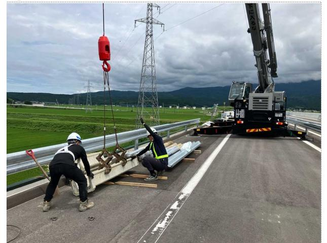
林建設工業株による破損施設の撤去作業
