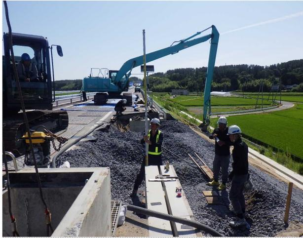
林建設工業株による路肩崩落部の盛土作業、排水構造物設置
