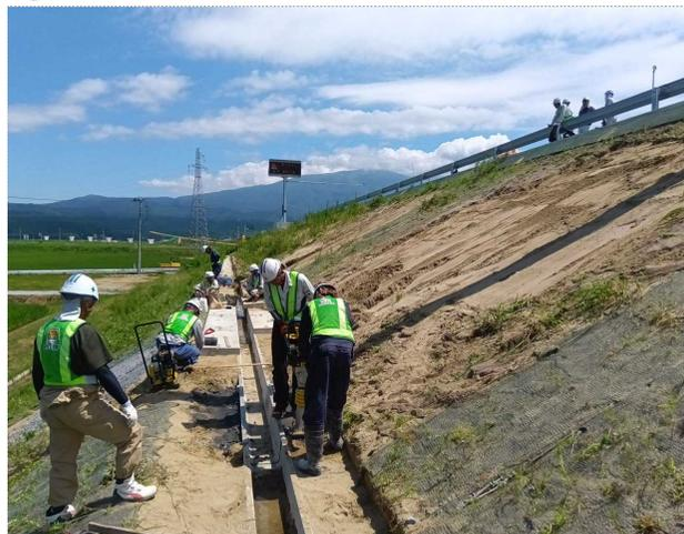
荘内土木株による排水構造物設置、小段締め
