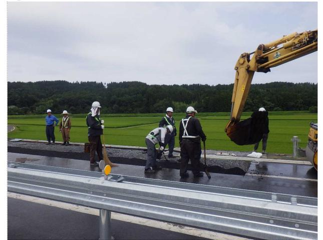
林建設工業株による路肩崩落部の舗設
