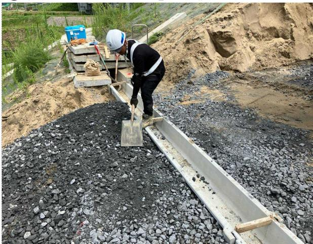
林建設工業株による排水構造物設置
