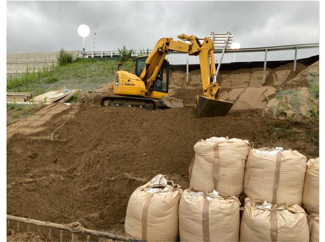
土のう設置、ブルーシートによる養生、導水管による排水処理
