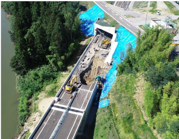
応急復旧\_掘削作業、破損施設の撤去作業
