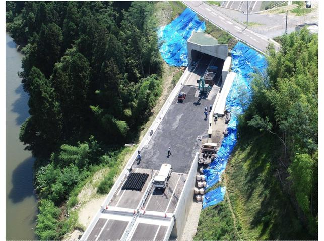
応急復旧\_路盤敷設、排水構造物設置
