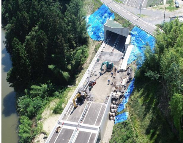
応急復旧\_本線盛土作業、排水構造物設置
