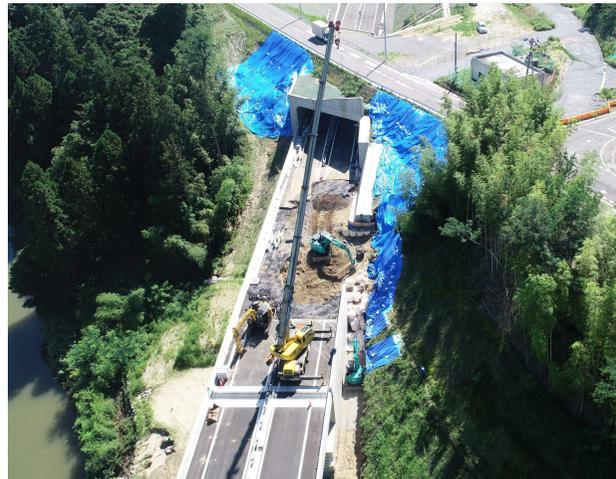
応急復旧\_アスファルト殻撤去、盛土前基面整正
