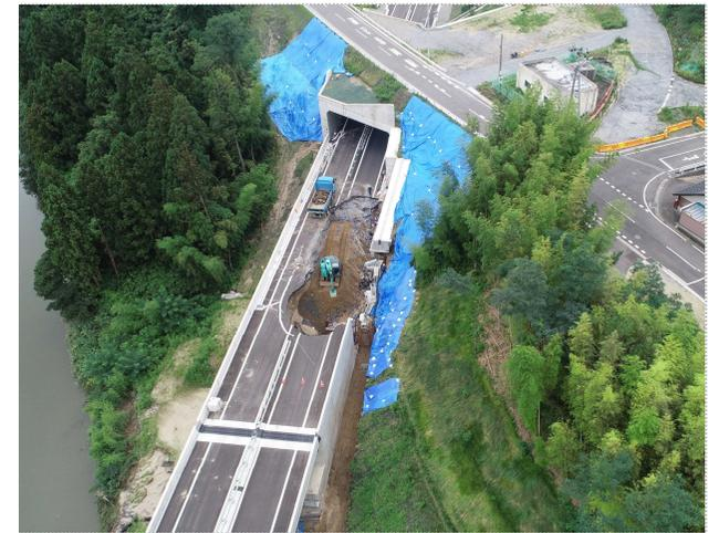
応急復旧\_破損施設の撤去作業
