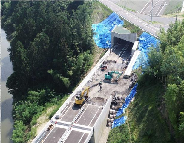
応急復旧\_排水構造物設置、ケーブル配管
