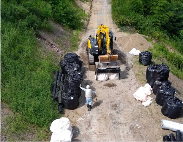
庄司建設工業(株)による土のう製作・設置
