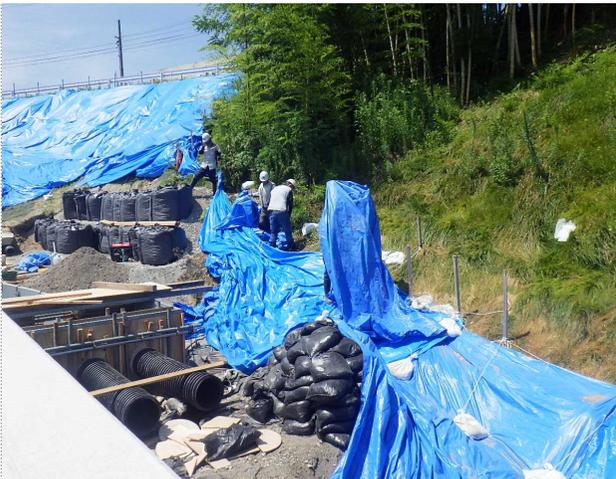
庄司建設工業(株)による排水構造物設置
