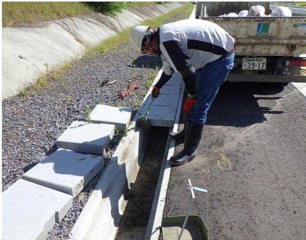
庄司建設工業(株)による側溝清掃・蓋設置
