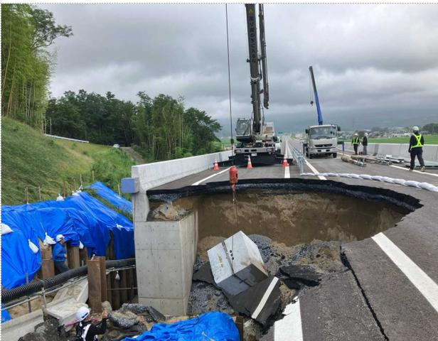
林建設工業(株)による破損施設の撤去作業
