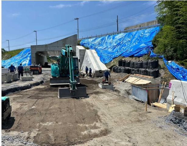
大井建設(株)による本線盛土作業、排水構造物設置
