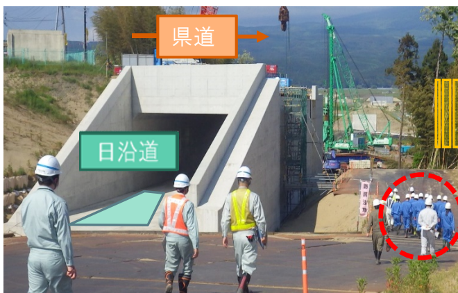
③最後は、月光川橋の隣にある完成した本線ボックスの中へ！
