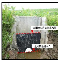
水位調整板の設置状況
