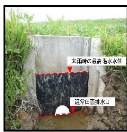
水位調整板の設置状況
