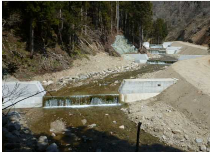
溪床の安定化を図る治山ダム
