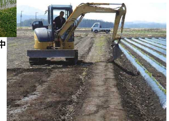
バックホウによる畦畔の嵩上げ
