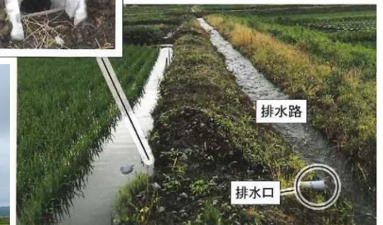
堰板による止水状況
