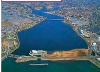
排水機場と周辺の市街地
