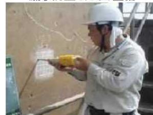
老朽化した施設の機能診断
