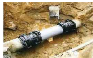
漏水防止のための整備
