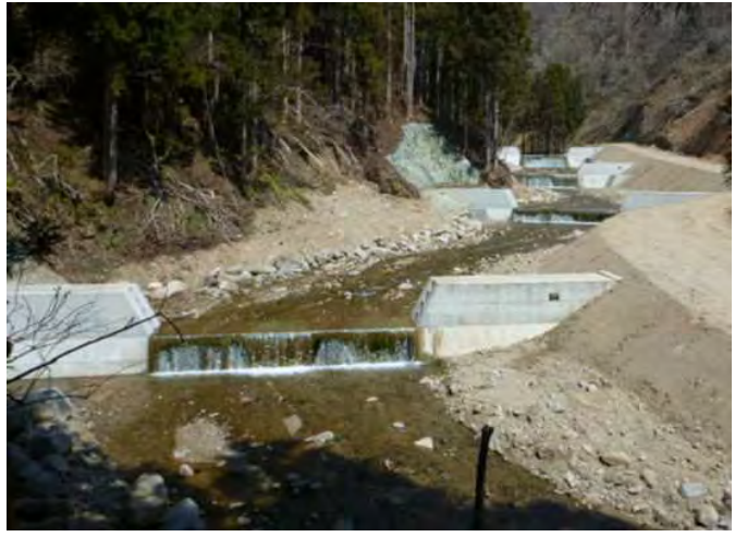
溪床の安定化を図る治山ダム
