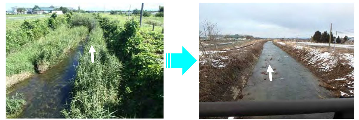
▲ 水無川(鶴岡市) 令和元年度実施 支障木伐採・堆積土砂撤去
