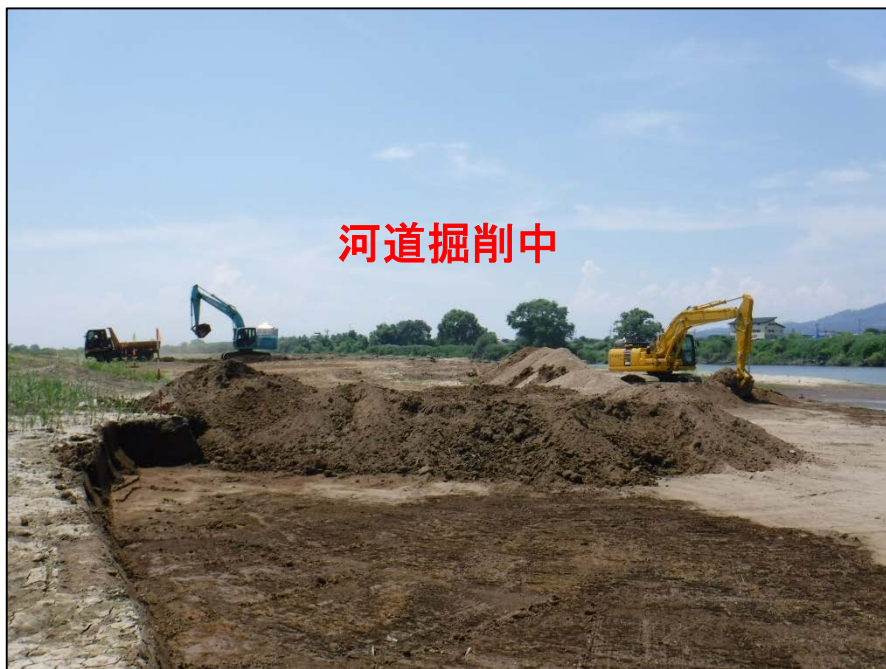
最上川上流長瀬地区河道掘削工事
