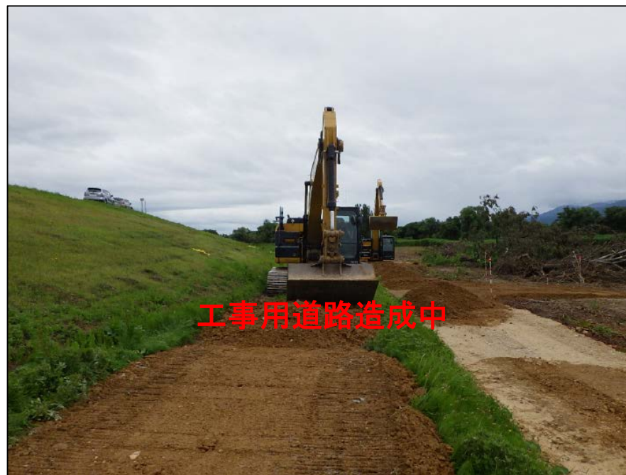
最上川上流谷地下流地区河道掘削工事
