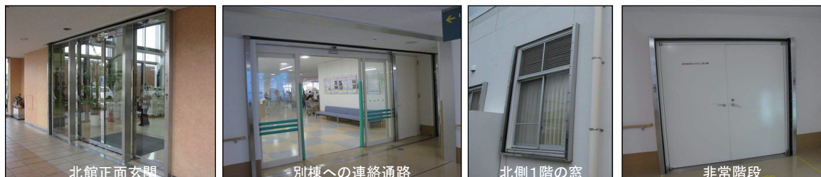
止水板のための角落としの設置
