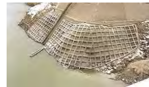
貯水池法面の保護
