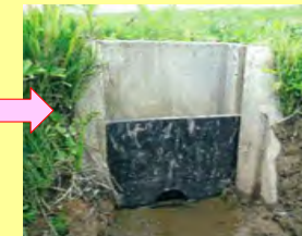
水戸板設置状況
