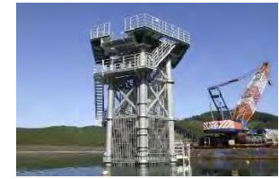
取水設備の整備
