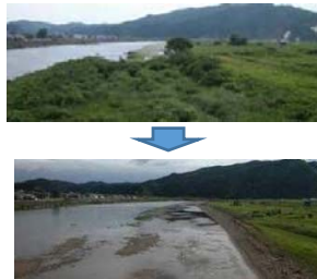
河道内樹木を伐採し洪水の疎通能力を向上
