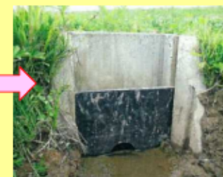
水戸板設置状況
