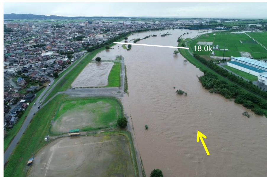
羽黒橋付近(18k)UAVにより上空から撮影 2020/7/28 17:30頃
