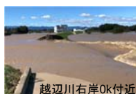
越辺川右岸0k付近
