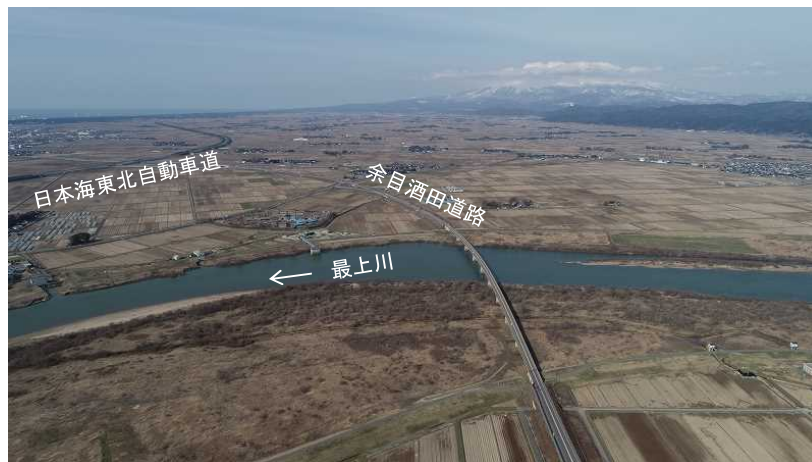
整備が完了した国道 47 号 余目酒田道路
