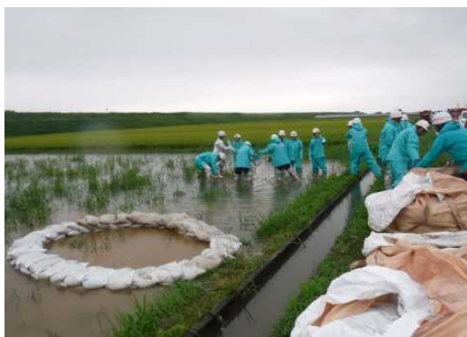
最上川での水防活動(釜段工)
