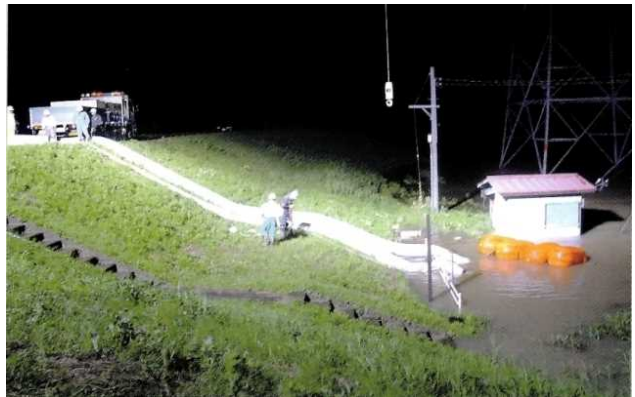
排水ポンプ車による内水排除状況
