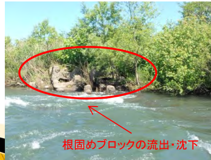
▲陸上から目視できない箇所を確認
