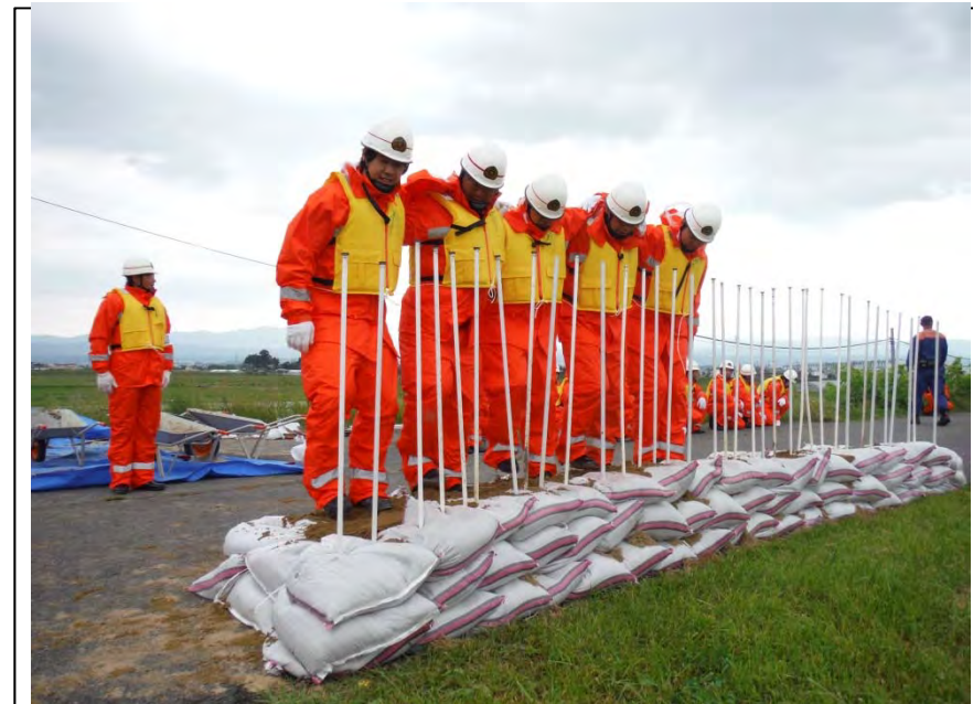
積み土のう工法
