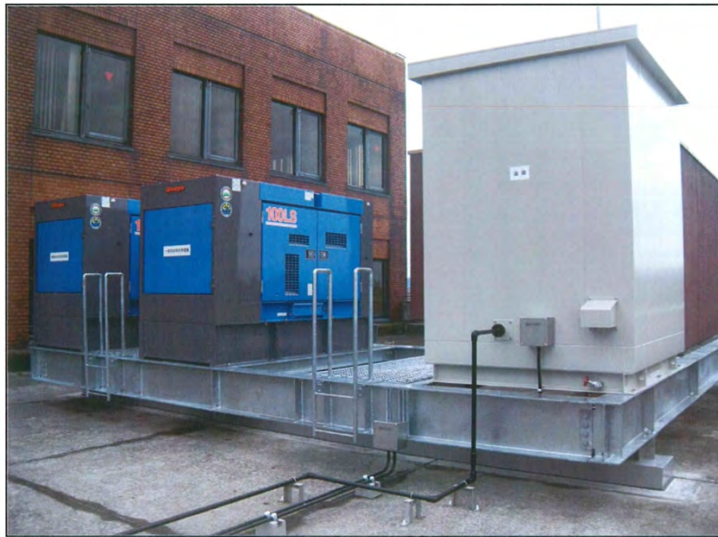
発電機、油庫設置完了
