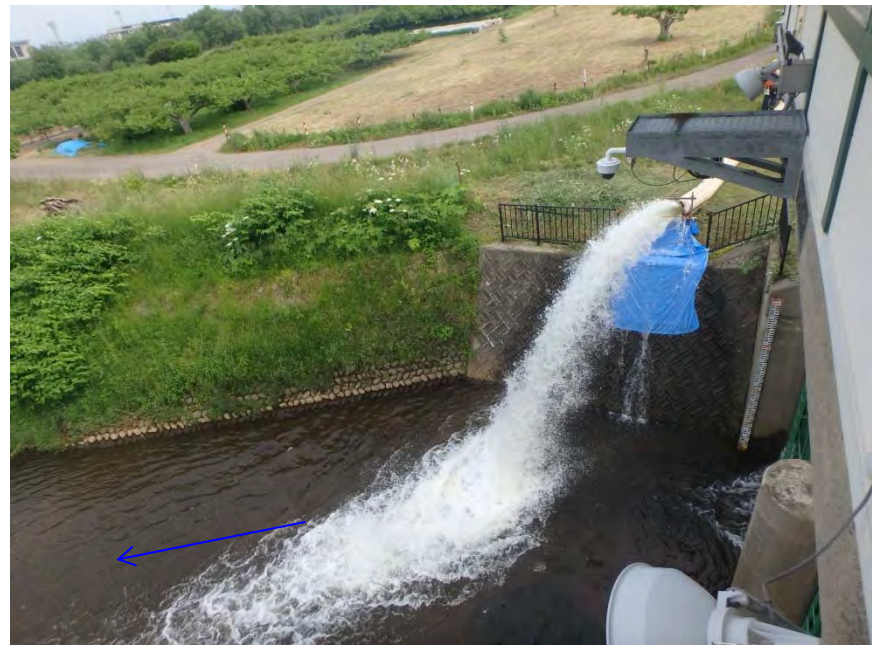
▲下流側 排水状況
