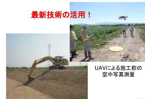
3DMCバックホウによる法面整形
