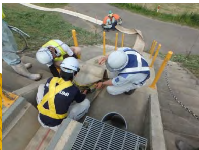
▲ホース設置作業状況
