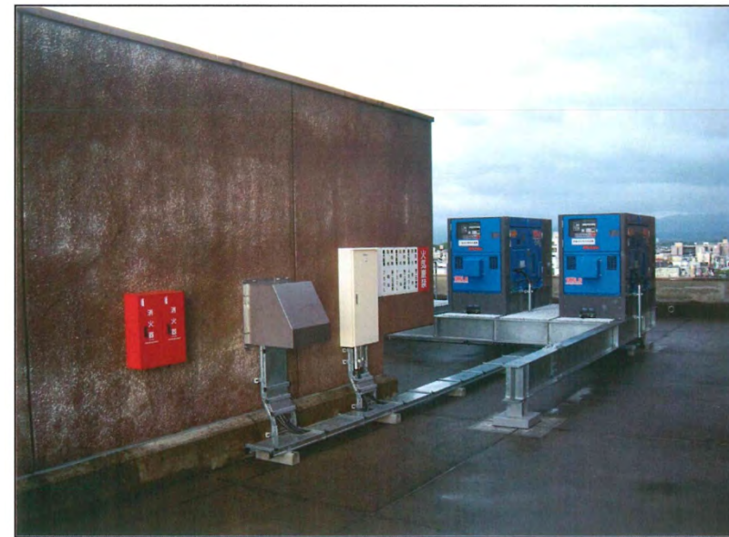
電源分岐盤等設置完了
