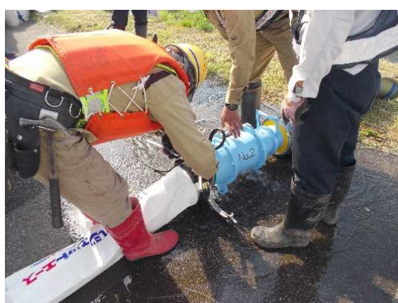
▲排水作業の準備状況
