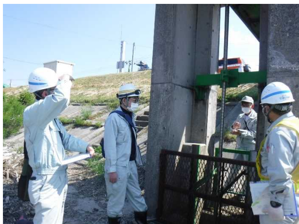
▲下瀬樋管点検(庄内総合支庁と合同)
