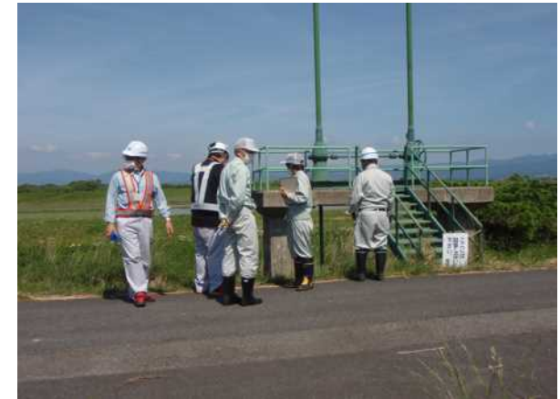
▲道形排水樋門（鶴岡市土木課と合同）
