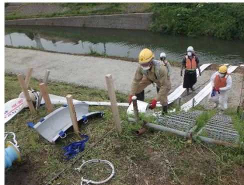
▲排水作業の準備状況
