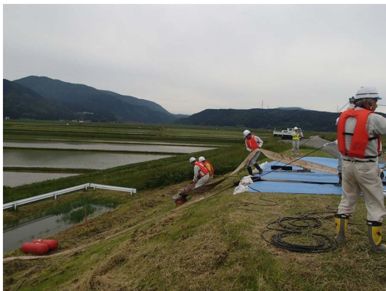
▲川裏側 排水ホース設置作業
