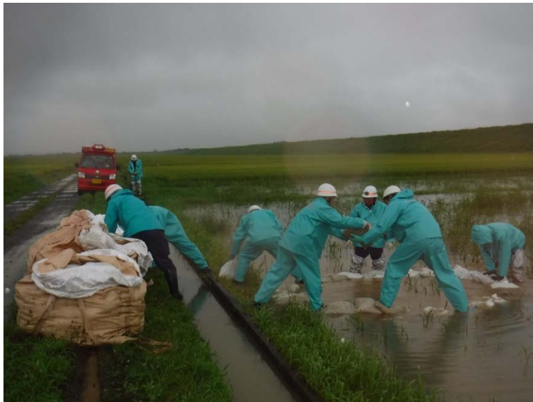
▲水防団が釜段工法により漏水の拡大防止に努めた
