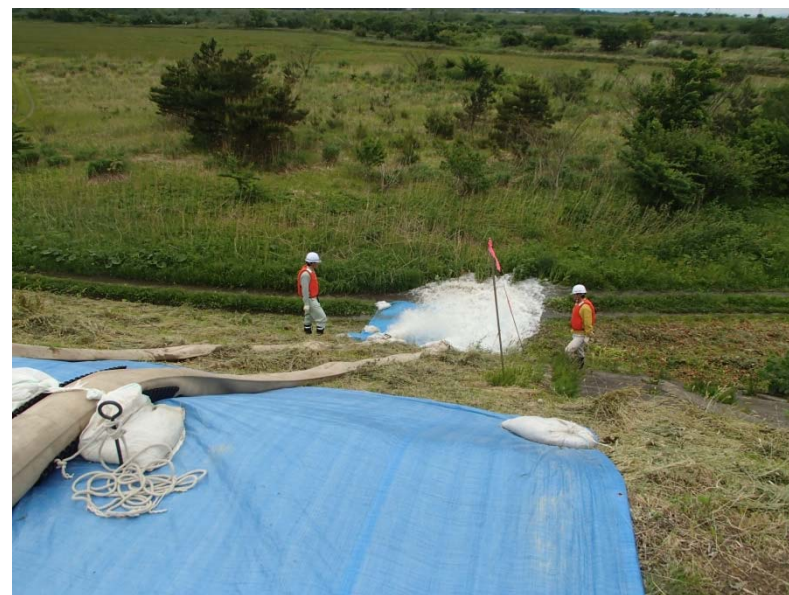
▲川表側 排水状況
