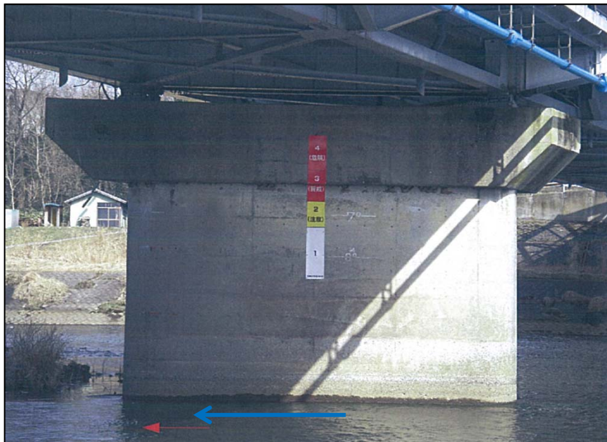
▲橋脚への両水標設置状況(日向川)
