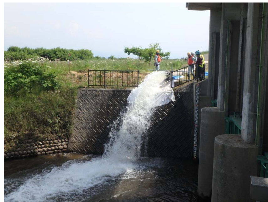
▲下流側排水状況
