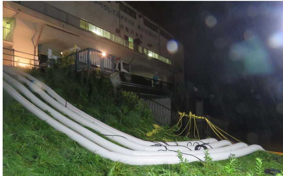
▲排水ポンプ車による新小牧川から最上川への排水作業
