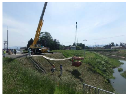
▲クレーンを使いポンプを設置
