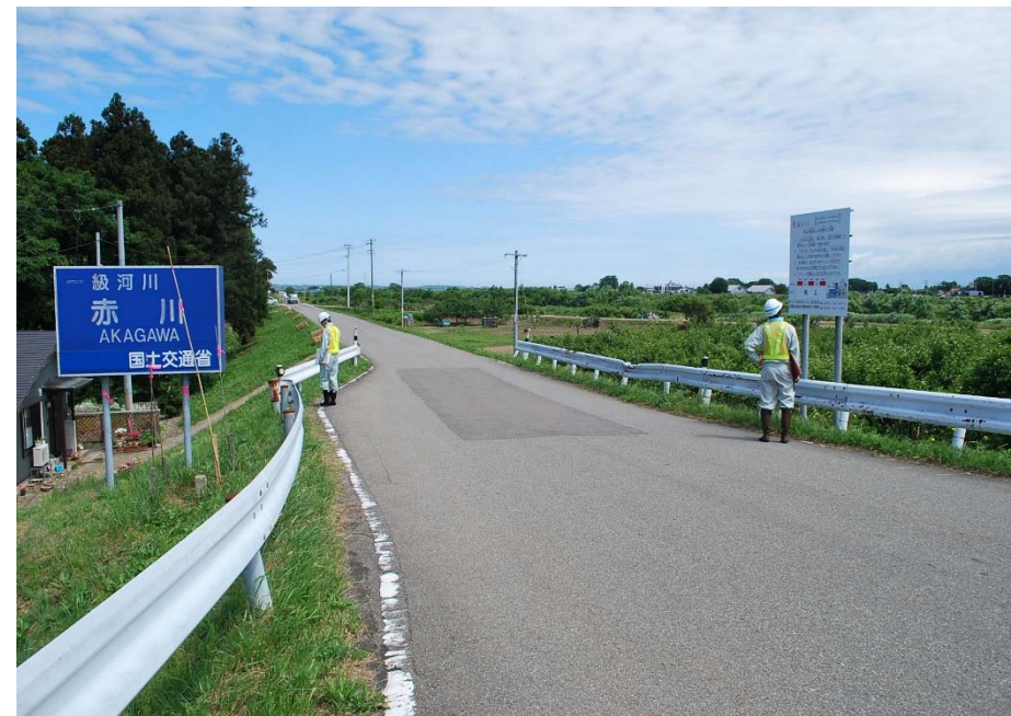
▲管理施設目視点検状況
