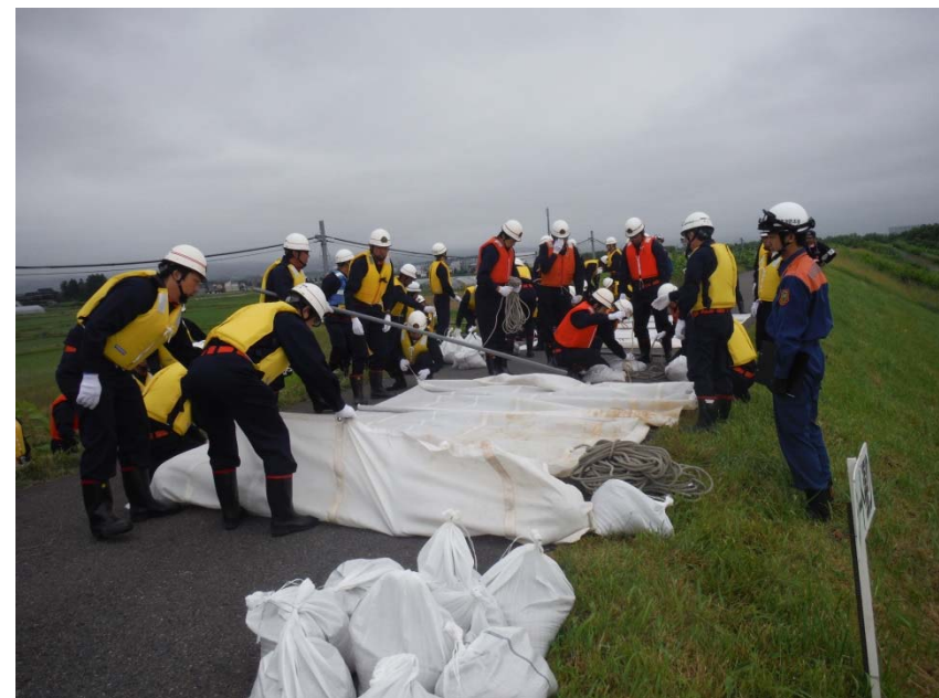
▲シート張り工法
