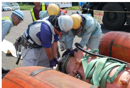
▲ホース接続作業
