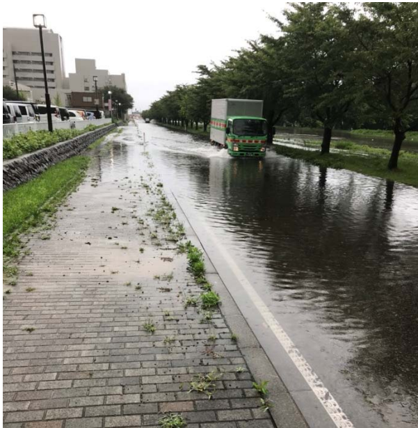
▲雨水などで新小牧川が増水し付近の道路が冠水
