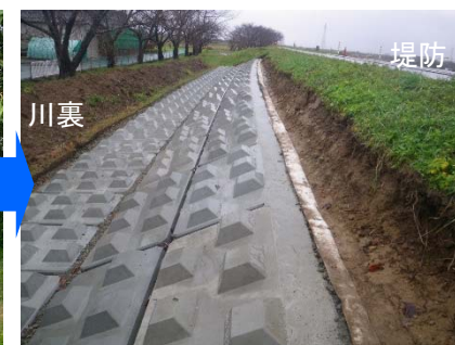
堤防裏法尻 ブロック設置後
