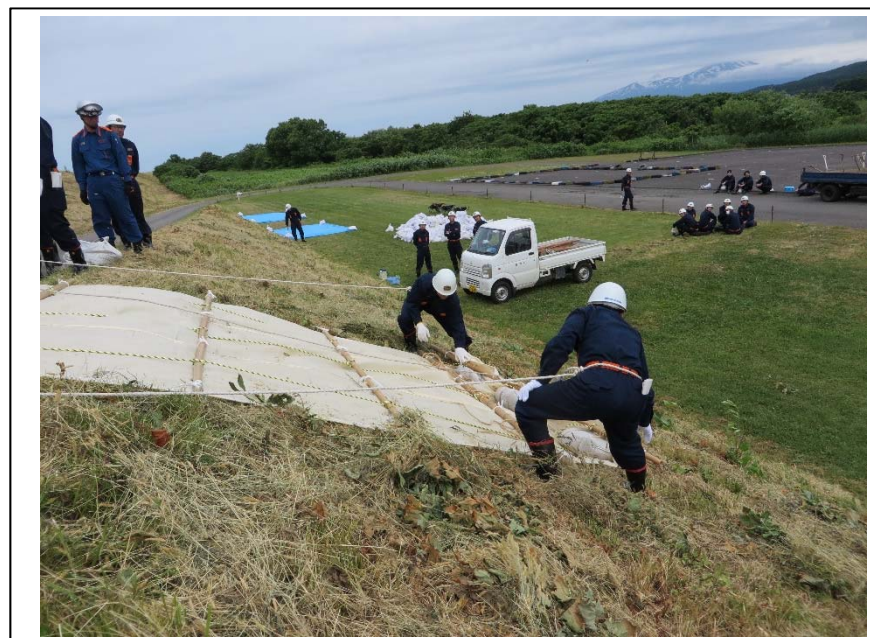
▲シート張り工法の実践の様子
