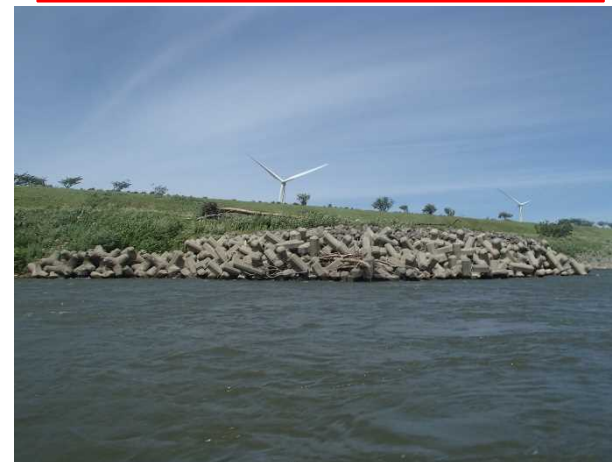
船上から見た河川管理施設(水制工)
