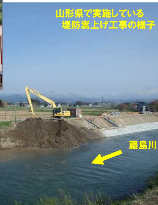
過年度に発生した河川氾濫箇所の堤防嵩上げ工事を視察
