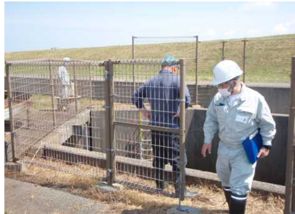
▲新浜広揚水機場（浜中広岡土地改良区と合同）
