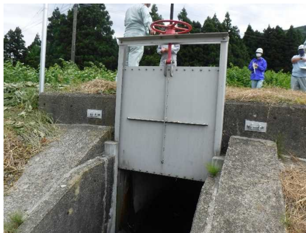
▲根堀沢排水樋管(大町溝土地改良区と合同)
