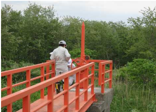
▲五ヶ村堰第2樋門（庄内赤川土地改良区と合同）
