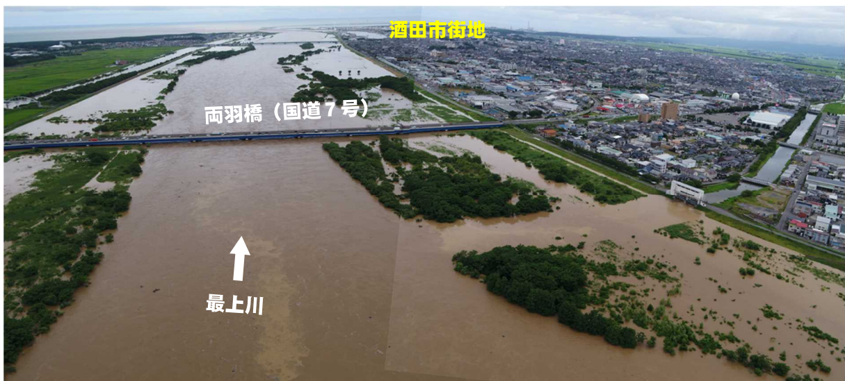
平成30年8月6日洪水：最上川本川の出水状況（酒田市落野目地区）
