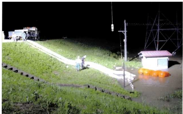
排水ポンプ車による内水排除状況
