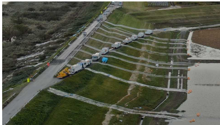
吉田川における排水作業状況
