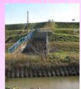
内浦緊急排水樋門（呑口部）
