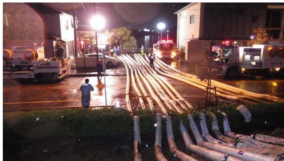
郡山市内の浸水箇所における排水作業状況
