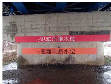
三川橋の水位表示
