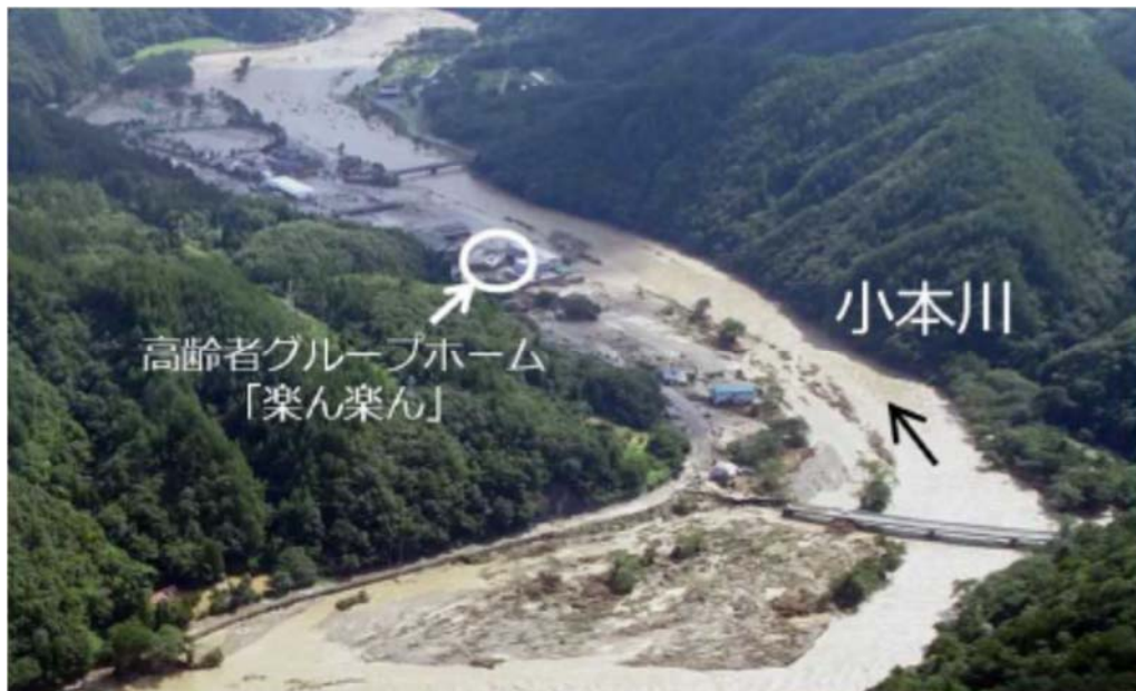
平成28年 岩手県台風10号災害 (出典：国土交通省水害レポート 2016)
