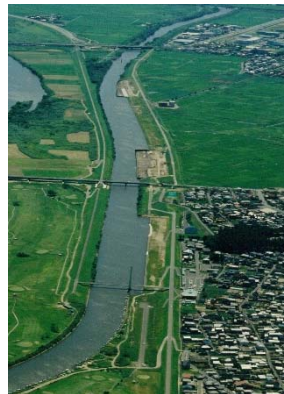
【引堤実施中の最上川支川京田川】
