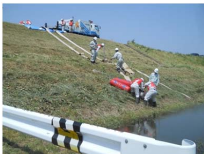
排水ポンプ車による排水訓練
