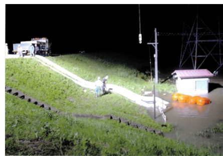
排水ポンプ車による内水排除状況
