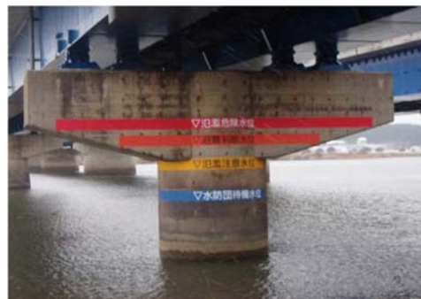
出羽大橋の水位表示
