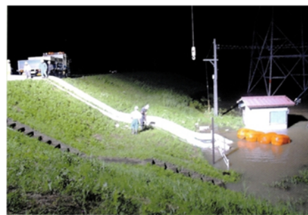
排水ポンプ車による内水排除状況
