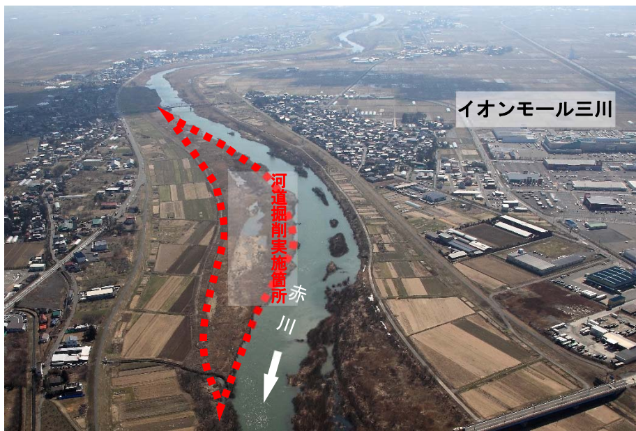
河道掘削実施箇所 航空写真
