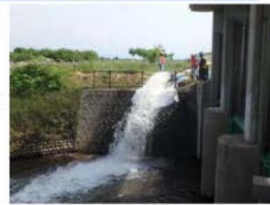
▲下流側排水状況
