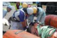
▲ホース接続作業
