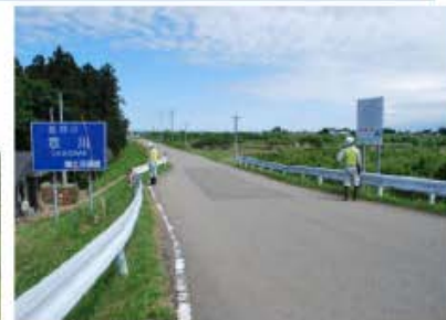
▲管理施設目視点検状況
