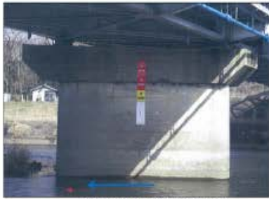
▲橋脚への両水標設置状況(日向川)
