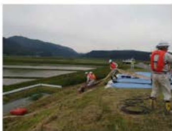
▲川表側 排水ホース設置作業
