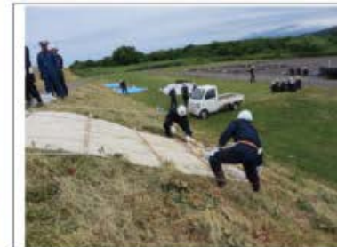
▲シート張り工法の実践の様子
