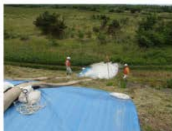
▲川表側 排水状況
