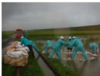
▲水防団が釜段工法により漏水の拡大防止に努めた
