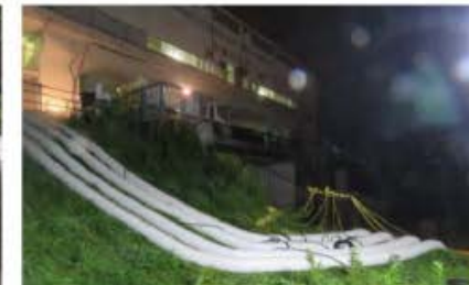
▲排水ポンプ車による新小牧川から最上川への排水作業
