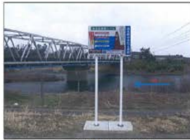
▲標示看板設置状況(日向川)
