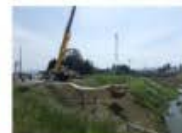
▲クレーンを使いポンプを設置
