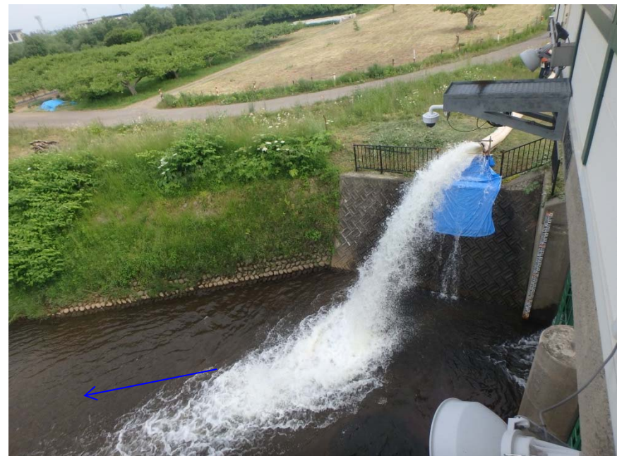
▲下流側 排水状況
