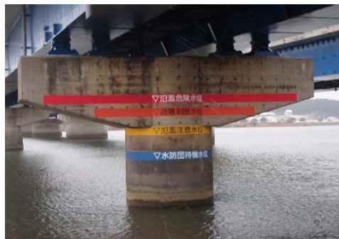
▲出羽大橋橋脚水位線標示状況
