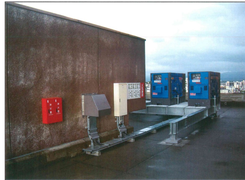
電源分岐盤等設置完了
