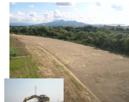
▲河道掘削箇所
