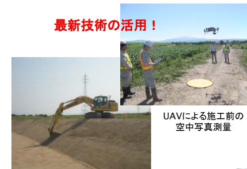
3DMCバックホウによる法面整形
