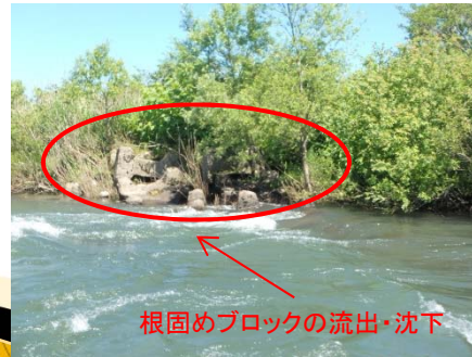
▲陸上から目視できない箇所を確認
