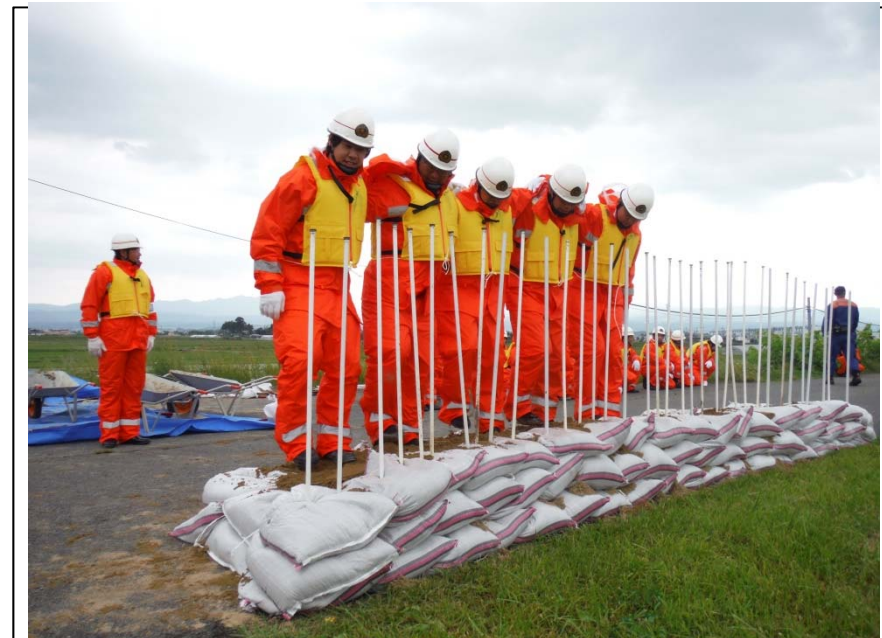
積み土のう工法
