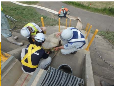
▲ホース設置作業状況
