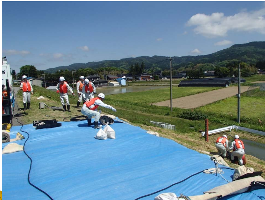
▲排水訓練実施状況
