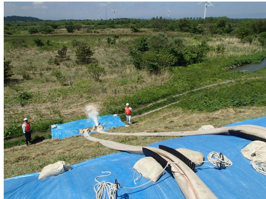
▲排水訓練実施状況
