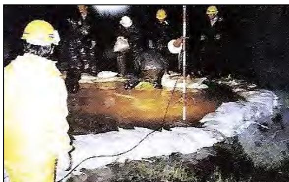
最上川での水防活動(釜段工)
