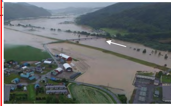
浸水状況(北見市)
