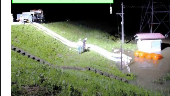
排水ポンプ車による内水排除状況(酒田市新堀地区)
