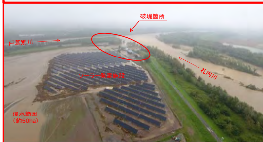
札内川の堤防決壊状況(帯広市)
