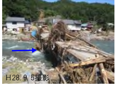
安家川 被害状況
