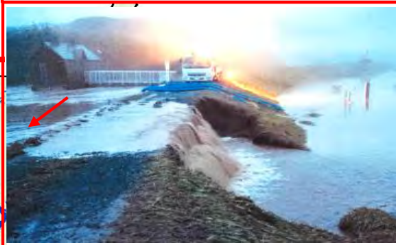
常呂川の堤防崩れ(北見市)
