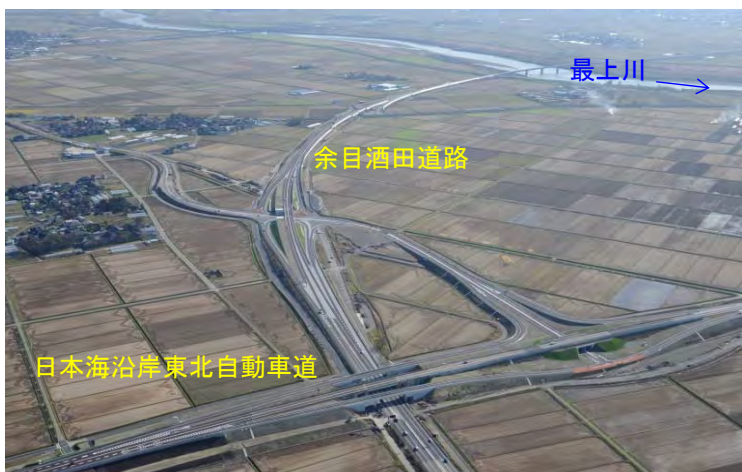
整備が進む国道47号 余目酒田道路
