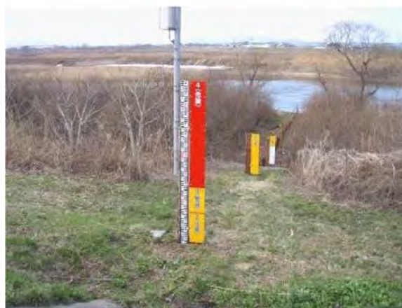
水位レベル標示の例
