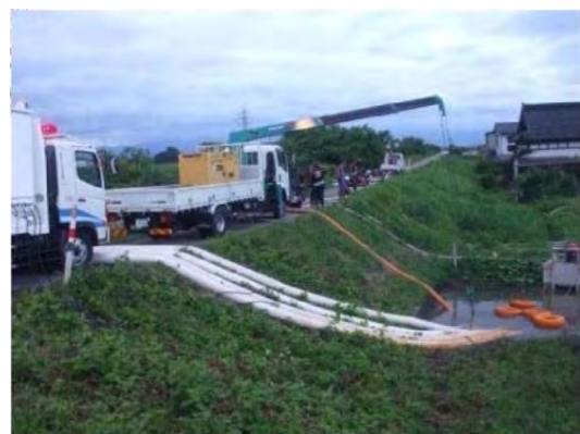
押切新田地区排水作業状況 内水を藤島川(最上川水系)へ排水
