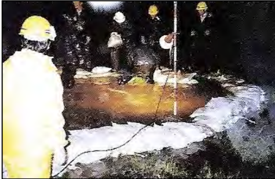
最上川での水防活動(釜段工)
