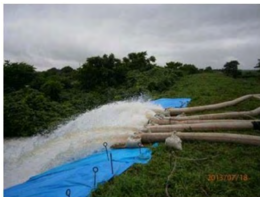
東沼地区排水作業状況 内水を大山川(赤川水系)へ排水
