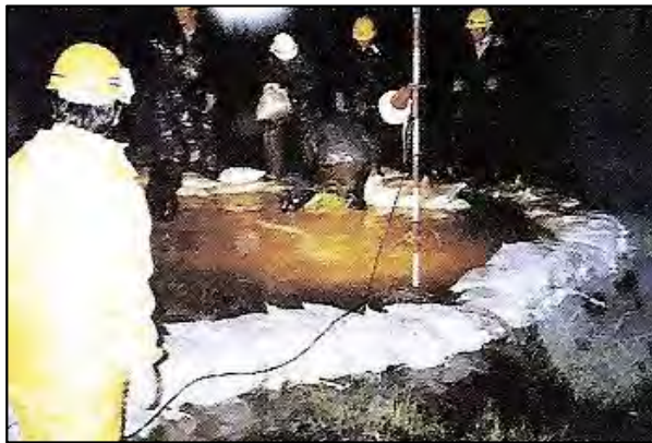
最上川での水防活動(釜段工)
