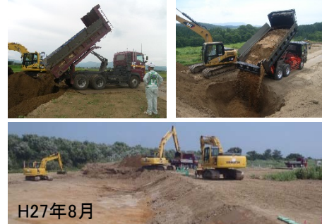
河道掘削の状況(湯野沢地区)・土砂運搬の状況(山形県)
