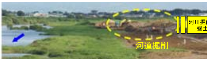
河道掘削の状況
