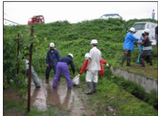
水防活動（漏水対策（月の輪工法）状況（赤川）
