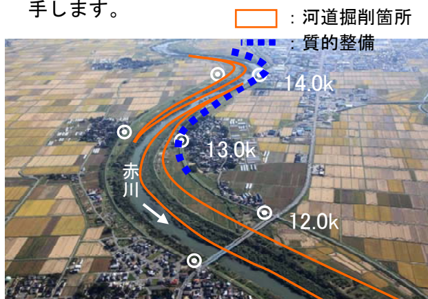
河道掘削及び堤防の質的整備箇所(13k付近)
