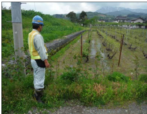
水防活動（漏水確認）状況（赤川）
