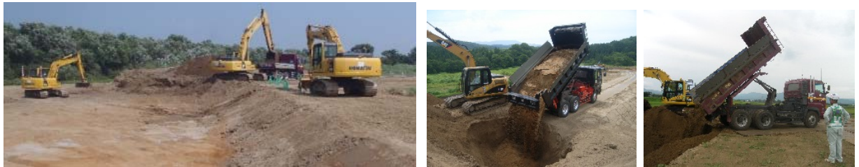
河道掘削（湯野沢地区）・土砂運搬の状況
