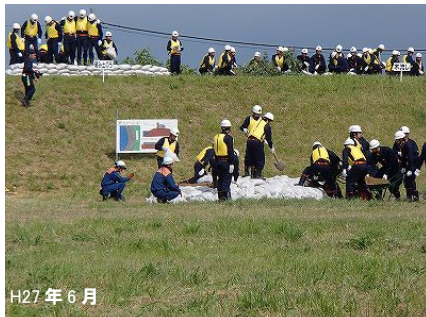
水防活動の様子(堤防漏水時の月の輪工法作業の様子)
