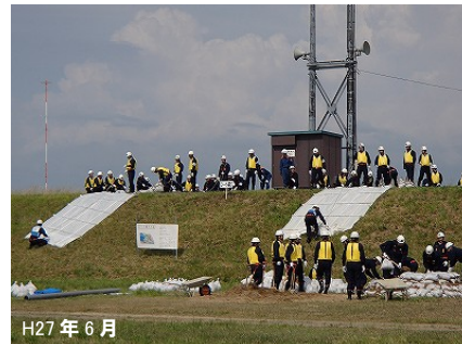
水防活動の様子(堤防漏水時の月の輪工法作業の様子)
