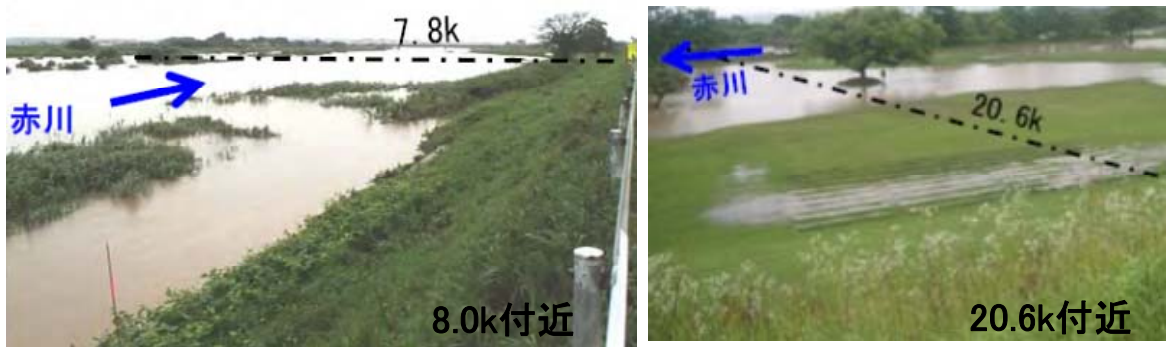
平成 26 年 7 月洪水の状況
