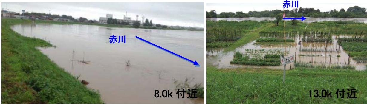
平成 25 年 7 月洪水の状況
