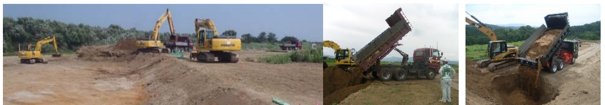
河道掘削の状況(湯野沢地区)・土砂運搬の状況(山形県)
