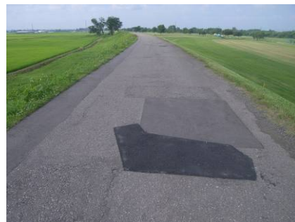
堤防の上面舗装補修後の状況
