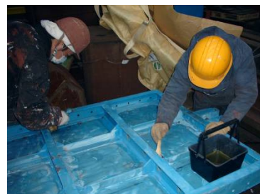
ゲートの補修状況
