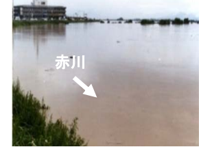
「計画高水位を越えた中流部」 (三川町上町付近)
