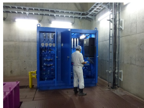
機械設備点検
