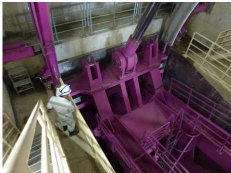
ダムのゲート点検
