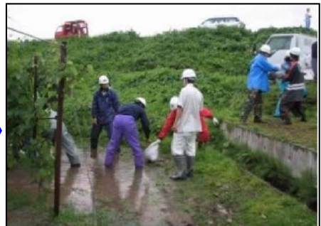
水防活動(漏水対策(月の輪))状況(赤川)
