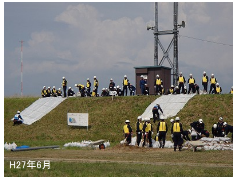
水防活動の様子(写真は堤防漏時の月の輪、釜段作業の様子)
