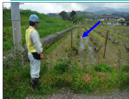
水防活動(漏水確認)状況(赤川)
