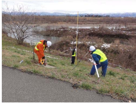
定期横断測量の状況
