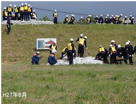
水防活動の様子(写真は堤防漏時の月の輪、釜段作業の様子)
