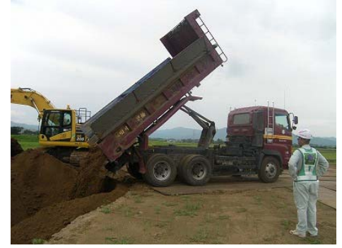
河道掘削の状況(湯野沢地区) 発生残土の提供先(山形県)運搬状況写真 河道掘削の状況と残土利用によるコスト削減
