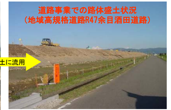
掘削土の道路事業での活用状況
