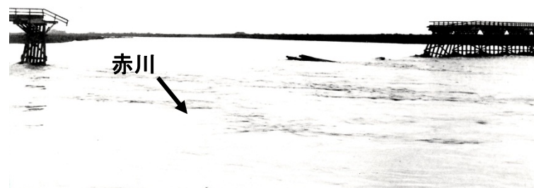
洪水により流失した菅原橋 (鶴岡市日出付近)
