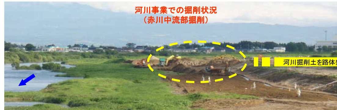
河道掘削の状況
