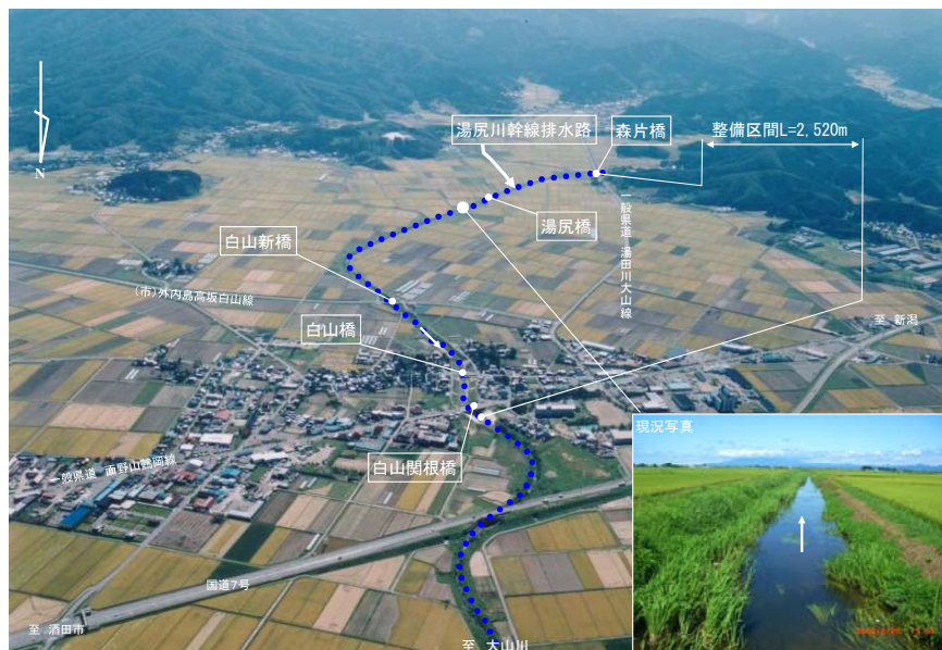
<河道の整備区間>
