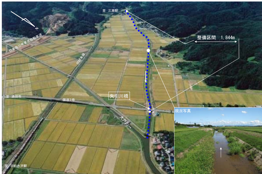
<河道の整備区間>
