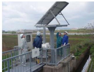
樋門・樋管の点検状況
