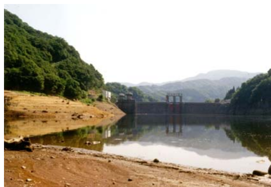
平成6年渇水時の荒沢ダム
