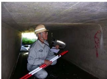
樋門函体内の点検
