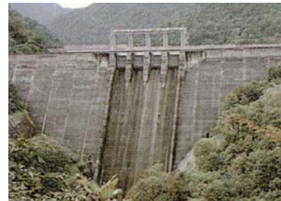
八久和ダム（昭和31年完成）
