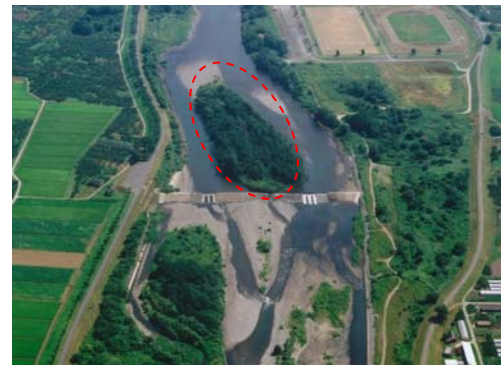
図 3-20 樹木の繁茂状況 (馬渡床止工付近)
