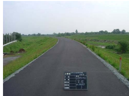
舗装後の状況
