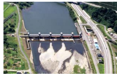
赤川頭首工（昭和44年完成）
