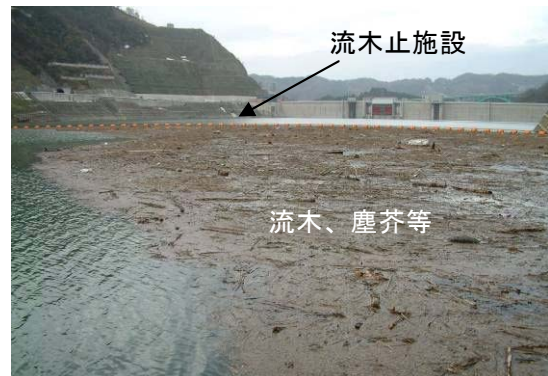
流木止施設による流木や塵芥の捕捉状況
