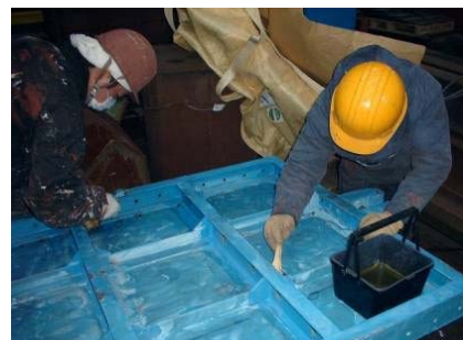
ゲートの補修
