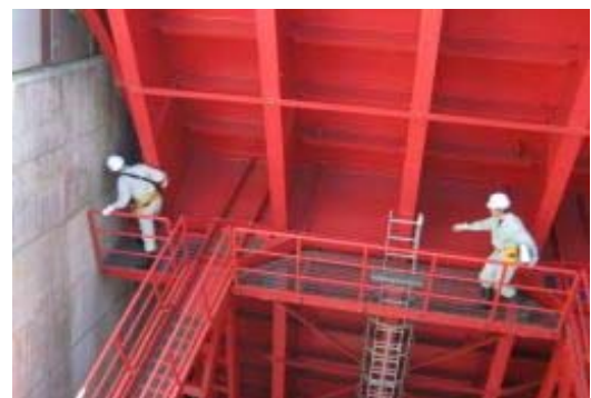
ダムのゲート点検の様子
