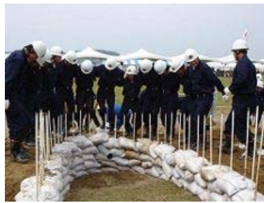
水防工法(月の輪工)の訓練
