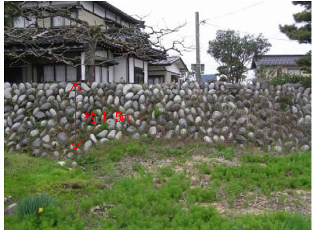
熊出付近の石積自衛堤
