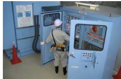
機械設備点検
