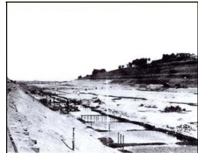
放水路開削工事の様子(昭和8年)
