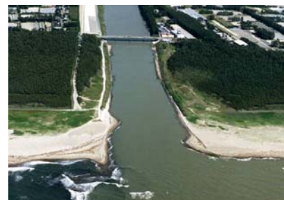
平成 9 年 5 月出水状況 (洪水後の河口状況写真)
