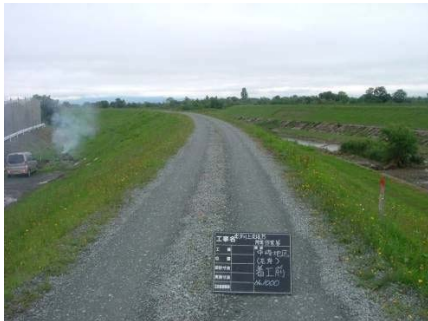
舗装前の状況
