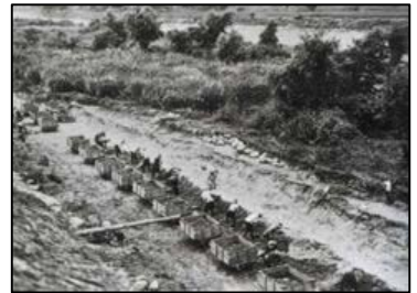
土砂運搬作業の様子(昭和8年)
