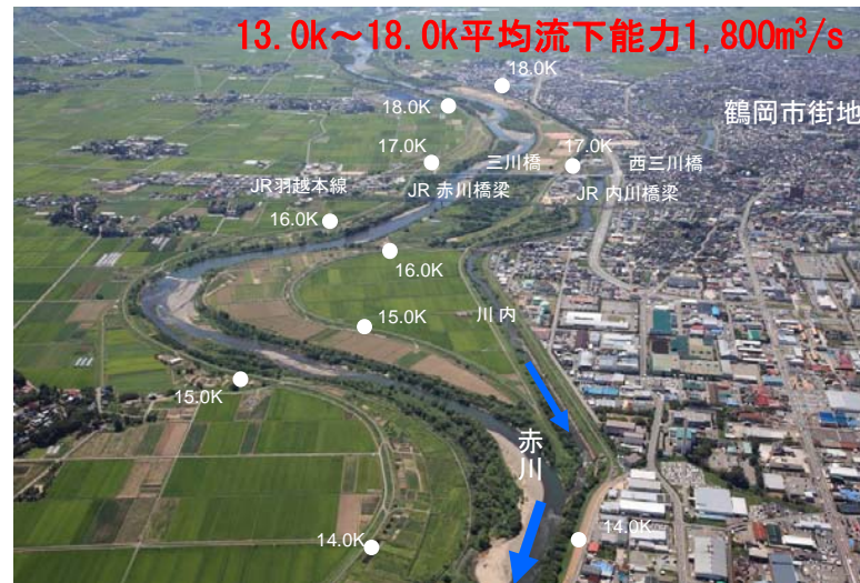
流下能力が不足している区間
