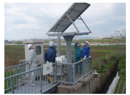
樋門・樋管の点検
