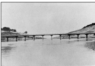
赤川放水路一部通水後(昭和3年)
