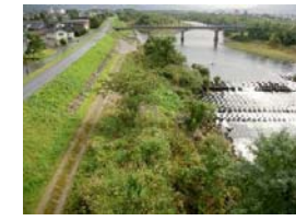
黒川床止 魚道設置前
