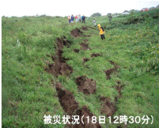
H19.9洪水による裏法面崩壊の例 (米代川左岸7.8km付近)
