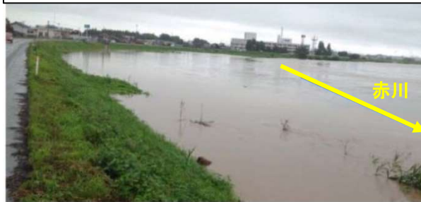
おしきり 押切水位観測所付近の出水状況
