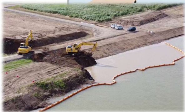
河道掘削の状況(文下地区)
