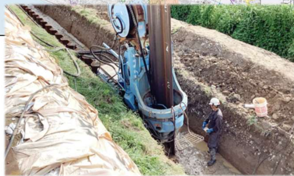
遮水矢板圧入状況(硬質地盤クリア工法) (文下地区)
