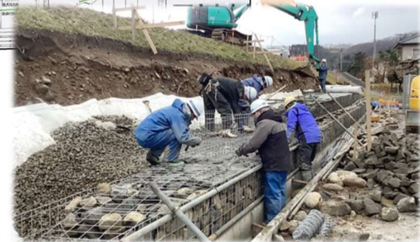
ドレーン工施工状況(熊出地区)
