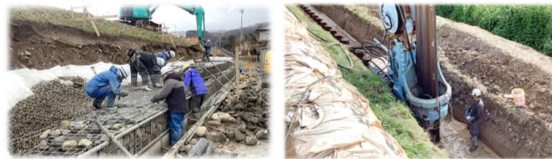
堤防の質的整備施工例
