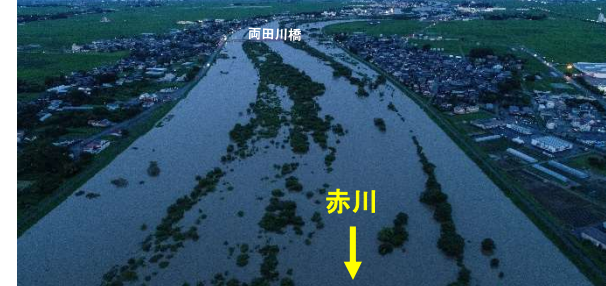
赤川下流(6.0k付近)の出水状況
