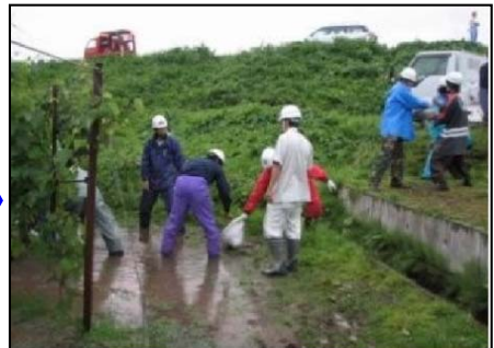
水防活動(漏水対策(月の輪))状況(赤川)
