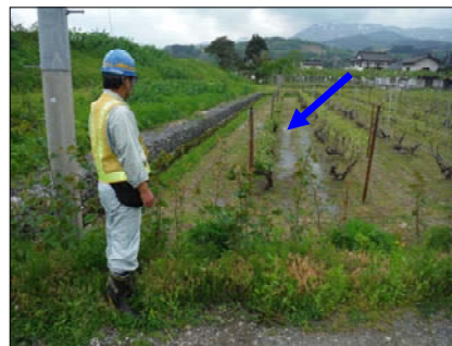
水防活動(漏水確認)状況(赤川)
