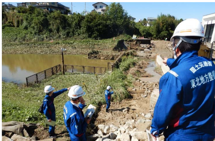
阿武隈川決壊箇所 調査状況
