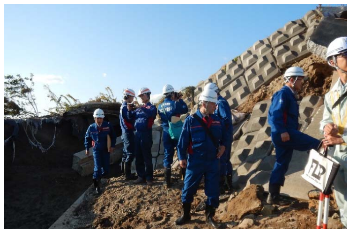
吉田川決壊箇所 調査状況
