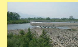
改築 (H13) により魚道が設置された馬渡床止工 (H17撮影)
