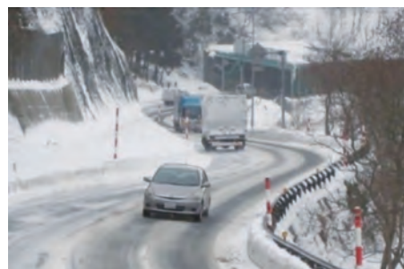
国道47号の急カーブ、路面凍結状況
