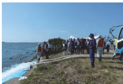
酒田市水防訓練での 排水ポンプ車による作業訓練
