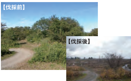
河道内樹木の伐採
