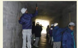
溝橋点検研修
