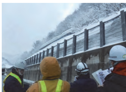
雪崩危険箇所点検
