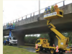
橋梁点検研修
