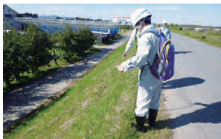
堤防や施設の点検
