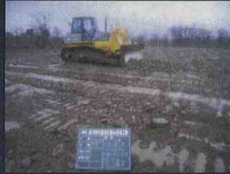
手順7：下層土の敷き均し
