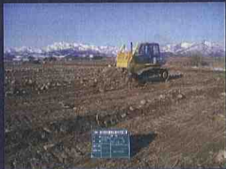
手順3：上層土の掘削押工
