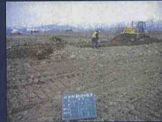
手順6：上層土の敷き均し
