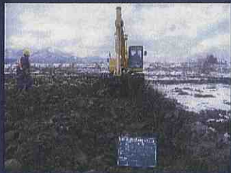
手順3：掘削の実施
