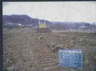
手順5：下層土掘削押工
