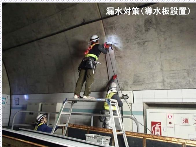
漏水対策(導水板設置)
