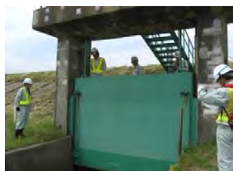
宮野満樋管を酒田市と合同で点検
