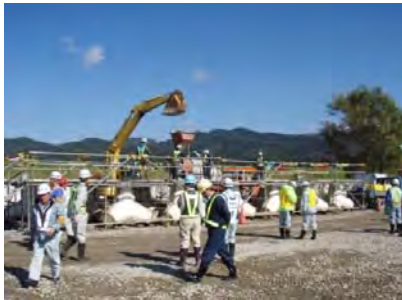
現場点検の様子
