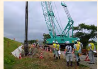
現場点検の状況
