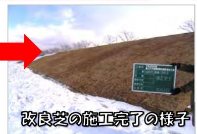
試験施工を実施した新技術は、他の植物が侵入しにくく改良した芝を使用した工法で、堤防の張芝で使用する一般的な野芝に比べ、施工性が向上し短い期間で施工できるうえ、施工後の維持管理において有利であるといわれているものです。
