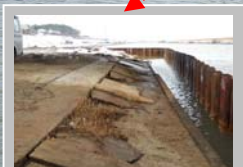
鉄の矢板を川に打ち込み、新しい護岸を作ります。
