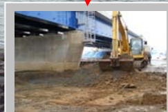
新しい護岸を作るため、バックホウで土を掘ります。
