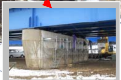
橋を検査するための通路を作っています。
